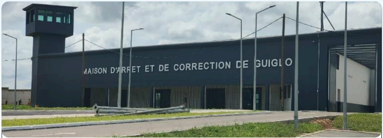
Construction de la Maison d'Arrêt et de Correction de Guiglo Génie Civil · BTP
